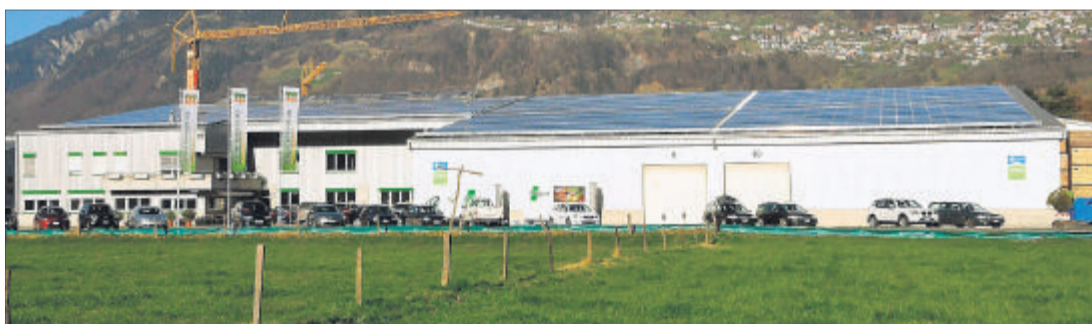
Einer der grössten Solaranlagen der Ostschweiz. (Bild: Heidi Beyeler)
